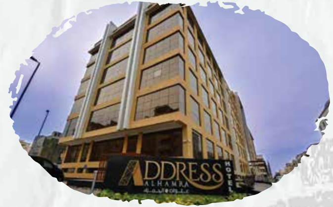
فندق عنوان الحمراء صيانة أنظمة مكافحة الحريق وأنظمة الإنذار المبكر ضد مخاطر الحريق.
