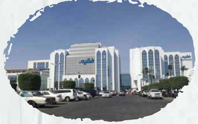
مستشفى فقيه توريد وتركيب أنظمة مكافحة الحريق وأنظمة الإنذار المبكر ضد مخاطر الحريق.
